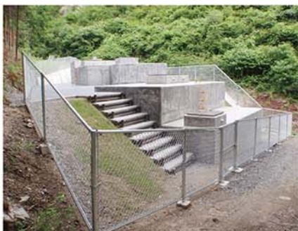
斜面の形状に沿って階段状に設置された改修後の深山水道
