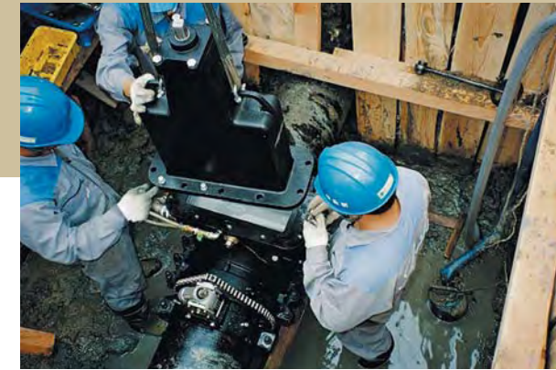
作業用仕切弁に弁蓋を取付けて施工完了(350mm)
