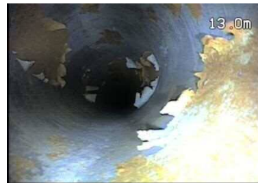
シーラコート剥離
