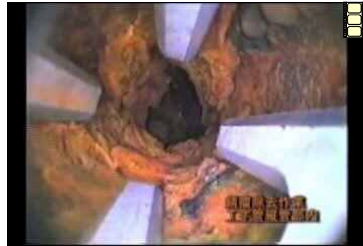
◆錆瘤除去作業(縦管部)
