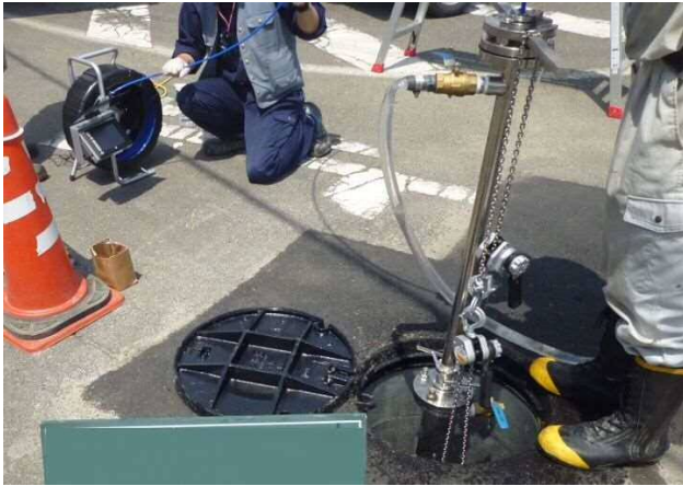
◆錆瘤除去作業(縦管部)
