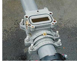
5. 穿孔機取外し
